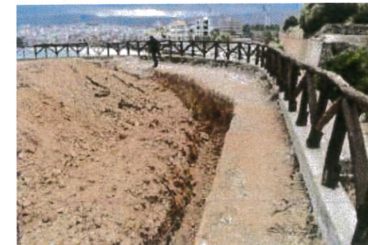
εικ. 24 Μπετονένιο στηθαίο και ξύλινο κιγκλίδωμα επί της στέψης του ενετικού τείχους
