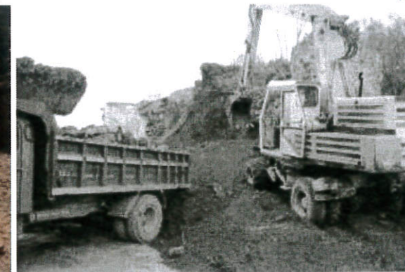
εικ. 18 Απομάκρυνση επιχώσεων με μηχανικά μέσα από τις αντηρίδες στη δυτική πλευρά της ανατολικής cortina- οδός Δευκαλίωνος (πηγή Εφορεία Αρχαιοτήτων Χανίων)
