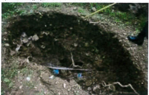
εικ. 35 Υποχώρηση εδάφους πάνω από υπόγειο χώρο
