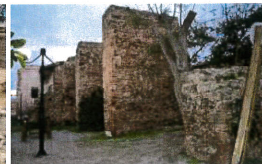
εικ. 20 Αντηρίδες στη δυτική πλευρά της ανατολικής Cortina - οδός Δευκαλίωνος
