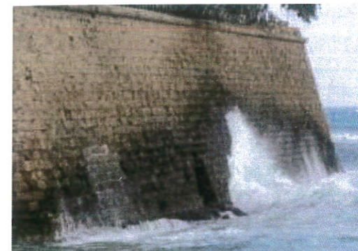
εικ. 41 Ανατολική όψη με κυματισμό – επιφανειακή χρωματική αλλοίωση (πηγή Φ. Τσαγάκης)
