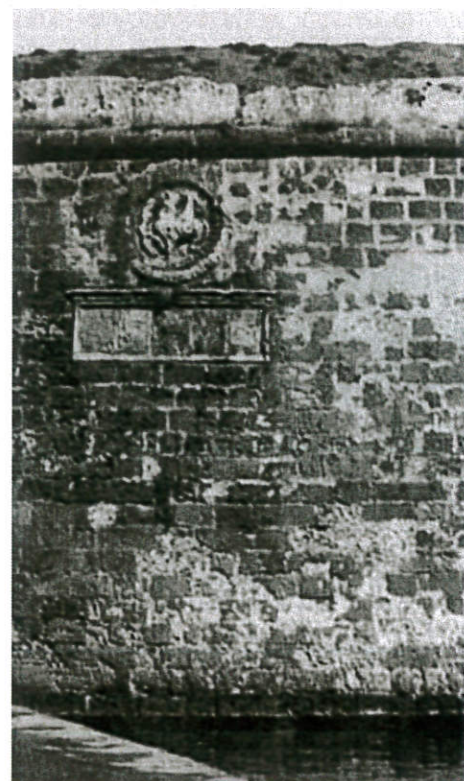
εικ. 40 Ρωγμή κάτω από το οικόσημο – Φωτογραφία αρχών 20ου αιω.
