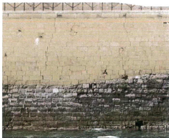
εικ. 38 Δύο διαμπερείς ρωγμές στην ανατολική όψη
