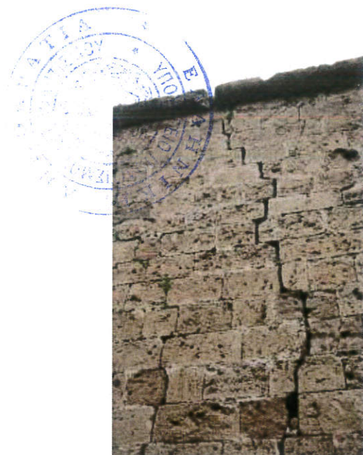
εικ. 37 Διαμπερή ρωγμή στη δυτική όψη
